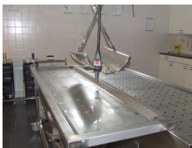
Foto 2. Wastafel voor een lichaam (hendels worden niet gebruikt) in de wasruimte bij de begraafplaats Zuylen in Breda.
